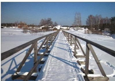
Мост через р. Вишня (2011 год)
